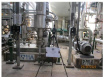
บริเวณปั๊มสุราฟรอม (Flash Drum Feed Pump)
