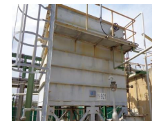
ถังปรับสภาพความเป็นกรด-ด่าง (Neutralization Tank)
