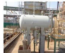
หน่วยแยกน้ำมัน (Oil Separator Unit)
